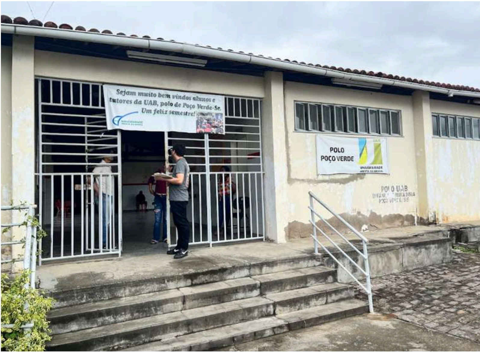
Figura 24 - Fachada do polo de Poço Verde
