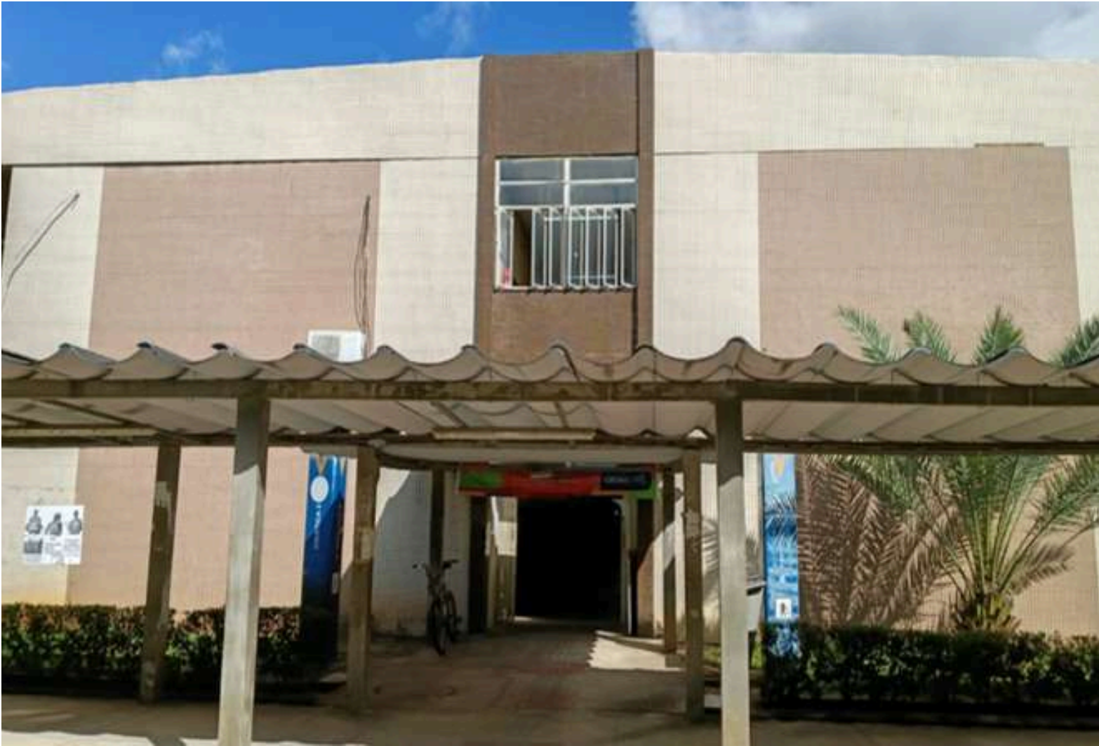
Figura 33 - Fachada do polo de São Cristóvão
