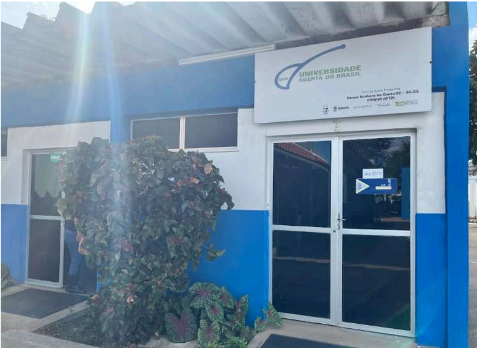
Figura 20 - Fachada do polo de N. Sra. da Glória
